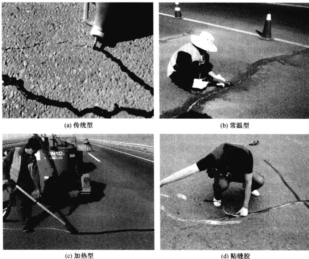
图 1-1 裂缝修补材料类型
