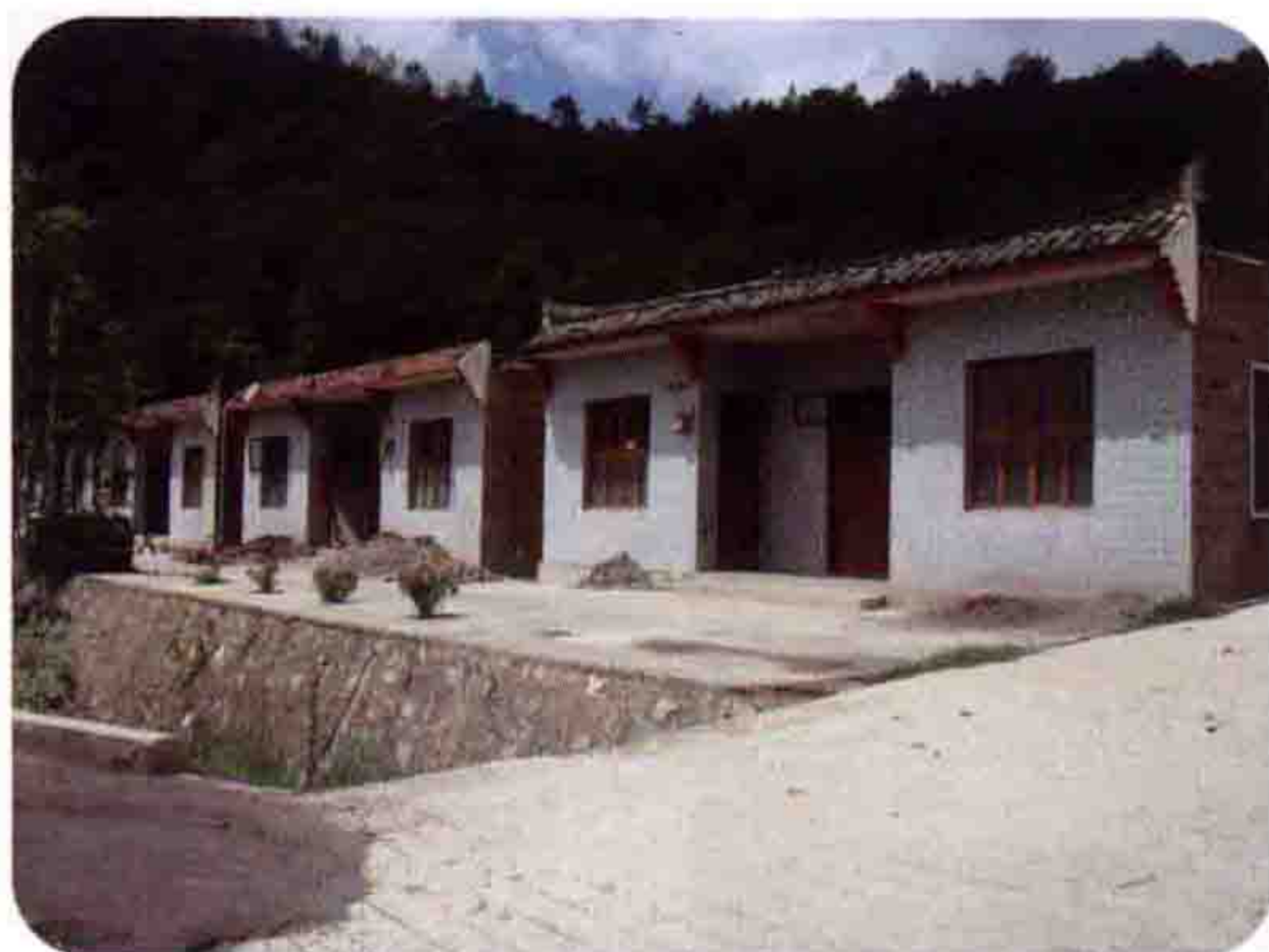
独山县羊凤乡桥头村坝浪寨的新民居
