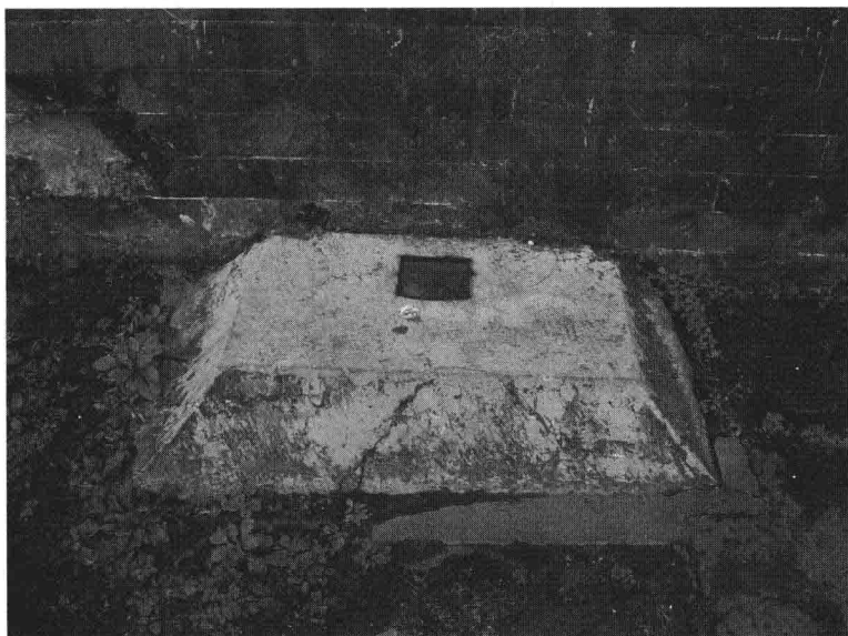
图九 孝陵明楼内部壁柱柱础（作者拍摄）
