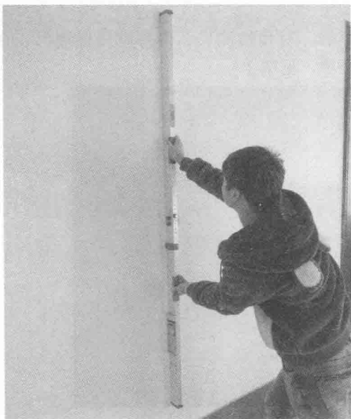
图 1-4 2m 检测器检测垂直度
