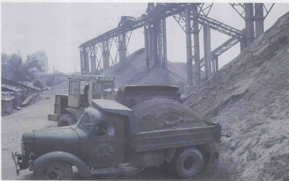
宜昌市装卸运输公司担斗车与翻斗车装运砂石料
