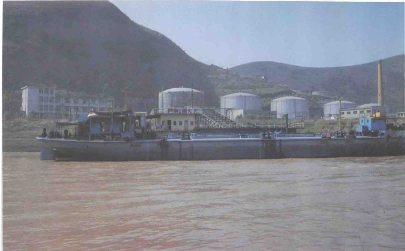
长航燃料供应站艾家河油库
