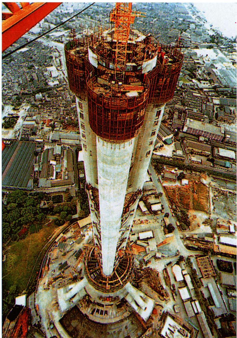
建设中的东方明珠
