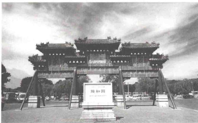
(a) 颐和园东门入口牌坊
