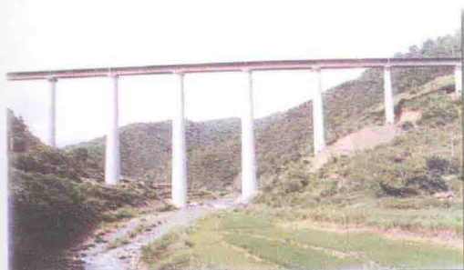
中铁二局施工段最高桥—潞城乐里河大桥,长301m,最高墩67m
