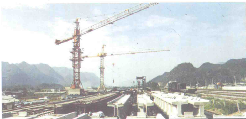
圆满完成那厘至八渡段940孔制梁任务的那厘制梁厂
