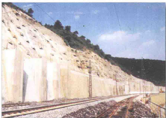
汪甸车站锚索护坡工程
