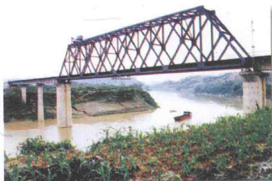
96m单孔大跨度钢桁梁右江大桥
