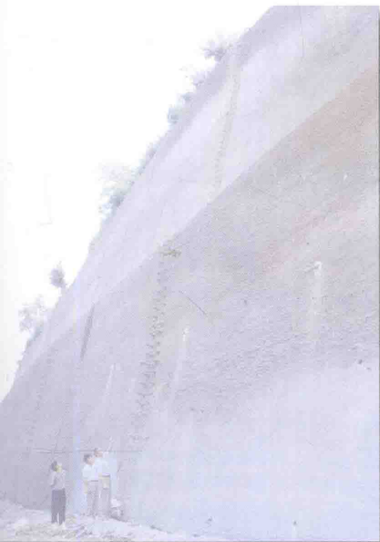
南昆线试验项目——土钉墙
