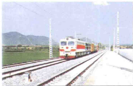
1997年8月26日南昆线那厘至百色112km, 27.5kV电化接触网送电合同一次成功, 图为热滑列车顺利运行
