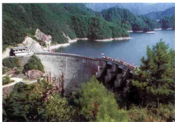
广丰县七星水库（广丰县七星水库管理局提供）
