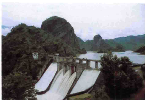
广丰县军潭水库（广丰县军潭水库管理局提供）
