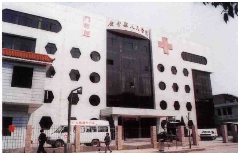
广丰县人民医院门诊综合大楼（广丰县人民医院提供）
