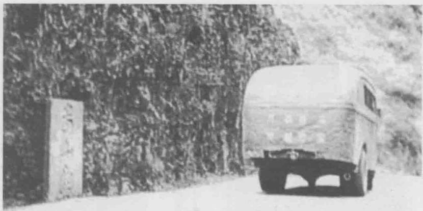
过去，除川黔干线邮路用汽车邮运以外，境内其余邮路均为人工步班邮运。此是一辆长途邮车正冒雪翻越娄山关。
