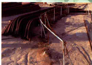
● 彩图3 钢筋拱架制作
