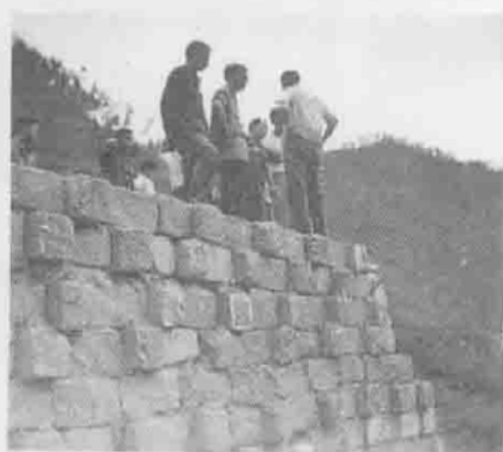
兵书宝剑峡顶过江铁塔塔基 (杨泽发 提供)
