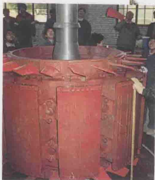
县水电开发公司在安装南阳河电站 6300KW 的立式发电机组。
