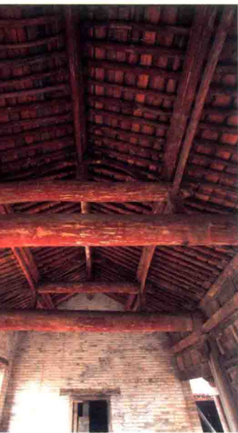
图 17-7 抬梁式屋顶结构
