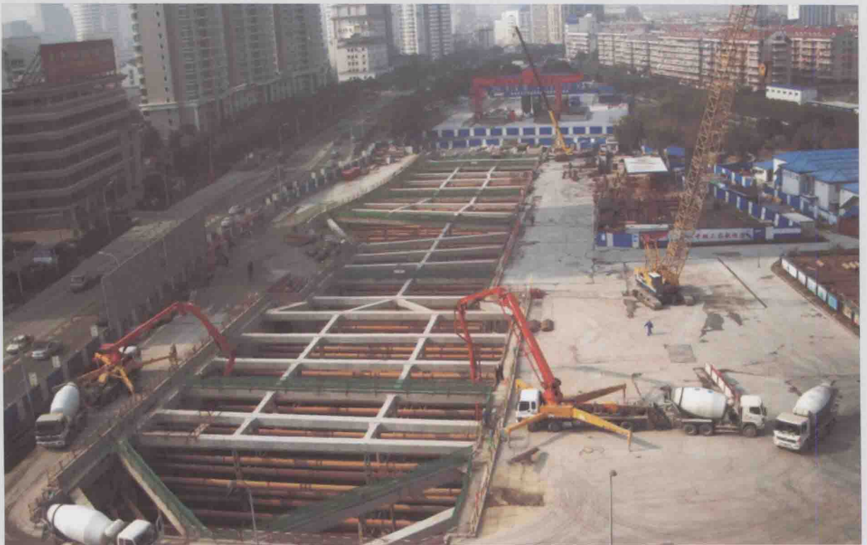
图11 樱花公园站异形基坑开挖
