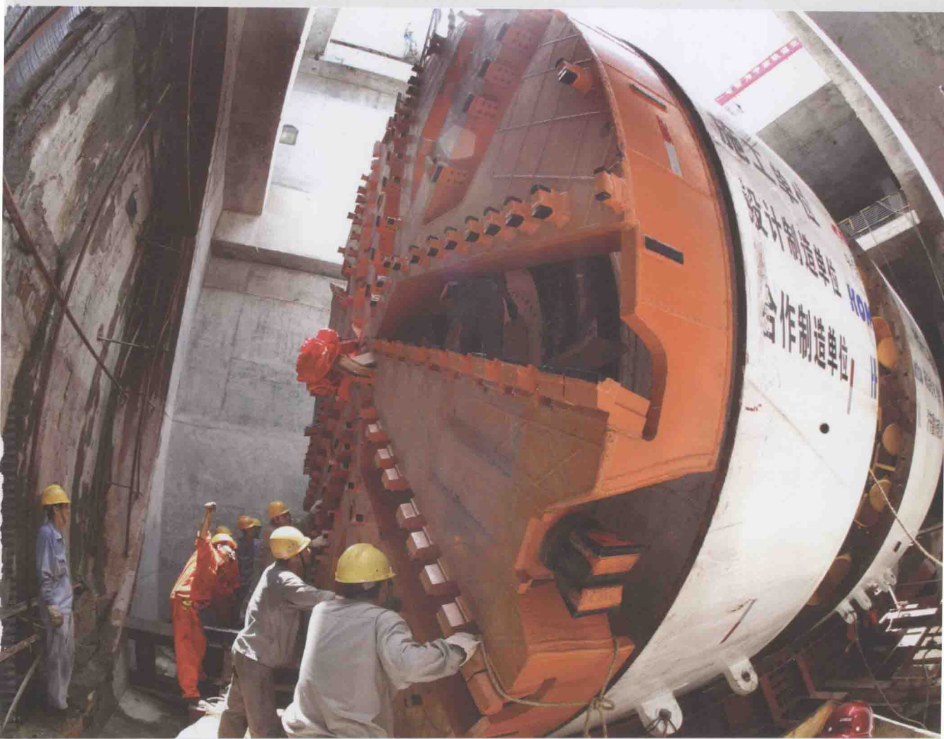
图1 宁波轨道交通首台盾构机始发（福明路站）
