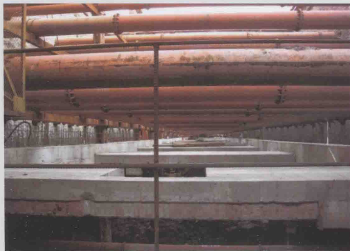
图7 鼓楼站下二层板撑合一施作法
