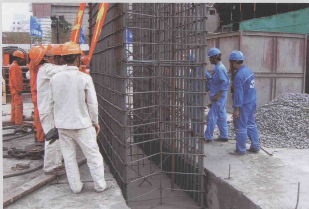
图14 地下连续墙现场施工
