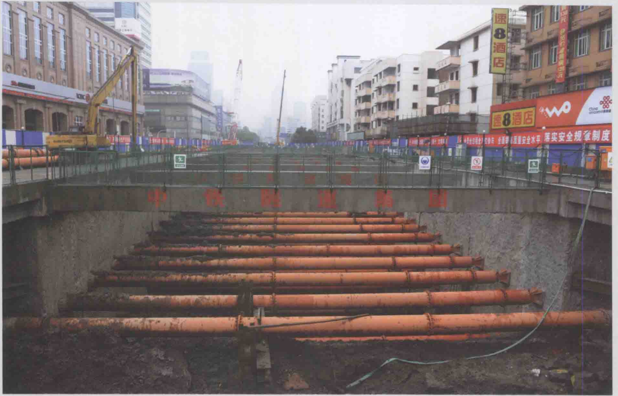
图10 西门口站基坑分层开挖图
