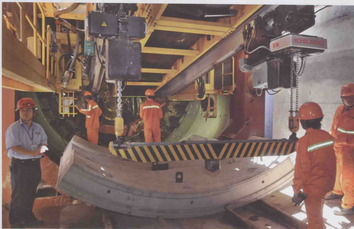
图4 现场管片安装
