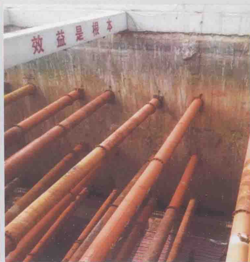
图8 地下连续墙施工质量控制效果图
