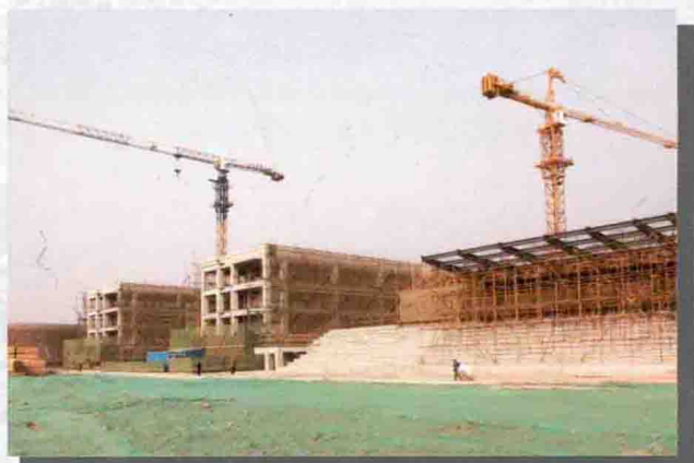
正在施工建设的滨海生态城学校
