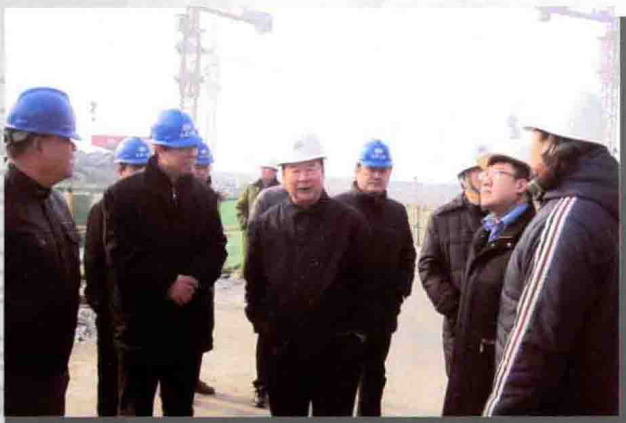
理事长孙海麟在滨海生态城学校工地与施工人员交谈
