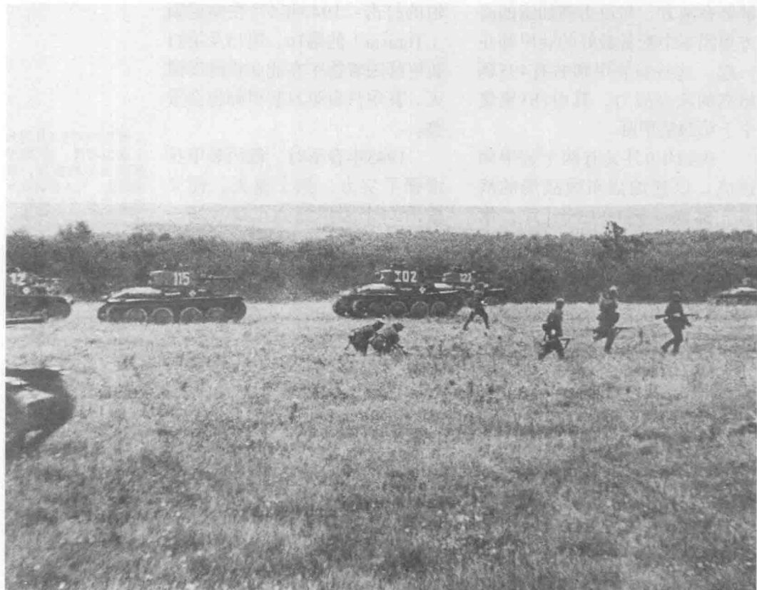
1 图为38(t)型坦克在入侵法国的战争中驶过法国北部。这些捷克制坦克是德国在战争初期的主要装甲武力。它以1门3.7厘米口径加农炮为主炮，配有2挺捷克制MG37型7.92毫米口径机枪，1挺为同轴，1挺在车身。这些坦克包抄行动缓慢的法军坦克，能轻易地打穿它们较弱的侧面装甲及履带。炮塔旁的战术编号以红底白字漆着，编号102的坦克是指挥车。
