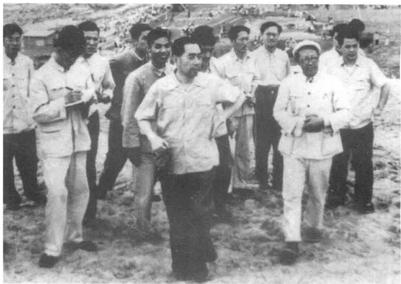
1959年6月7日,周总理视察正在建设中的岗南水库。 其左为石家庄专员张屏东,右为水电部副部长李葆华。
