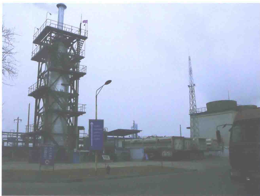
图 6 山东淄博中铝公司氯碱厂的副产氢气在装车外售，近处为给工厂供应蒸汽的氢气锅炉（2015年11月15日毛宗强摄）
