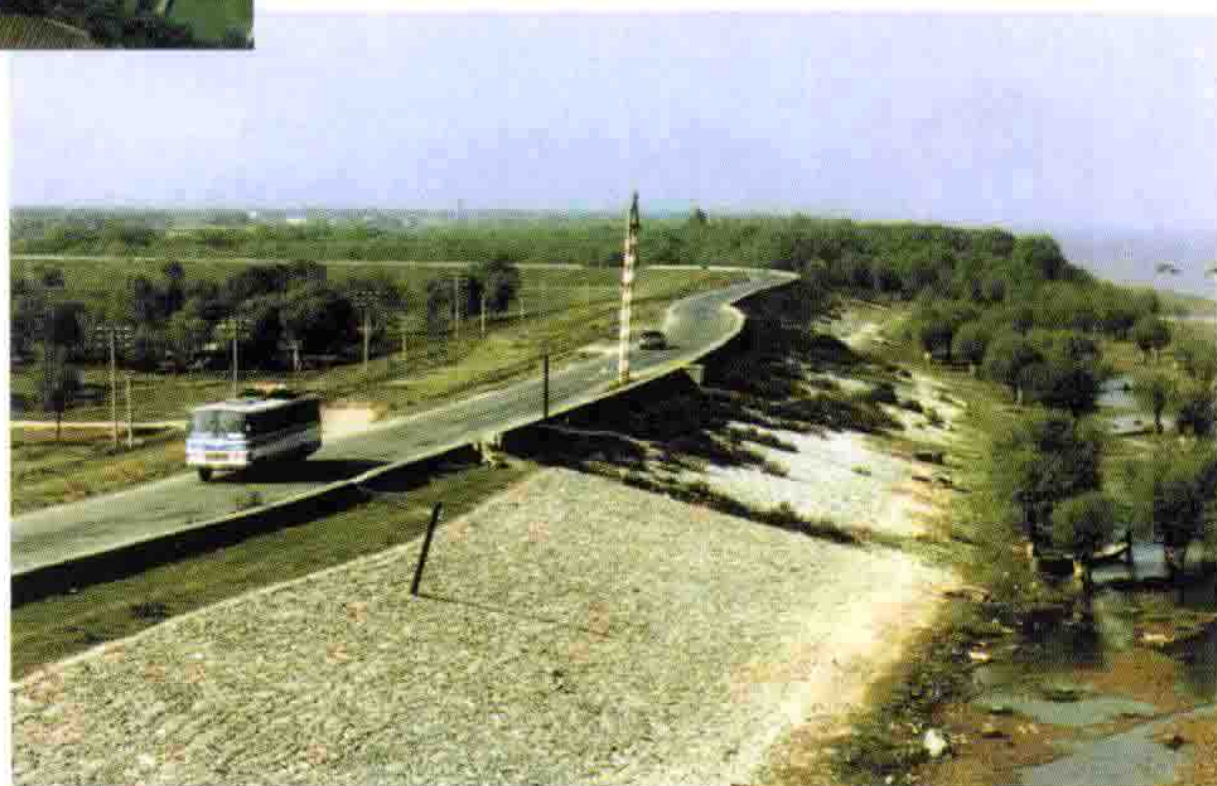
无为大堤二坝堤段
