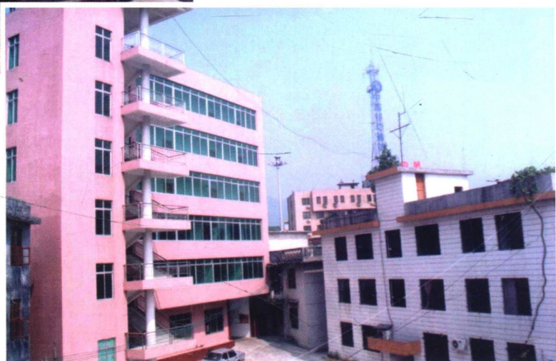
2002 年新建的连南县气象局 办公宿舍楼和综合楼
