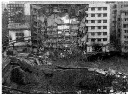
图 2.3 基坑旁居民楼墙体坍塌
