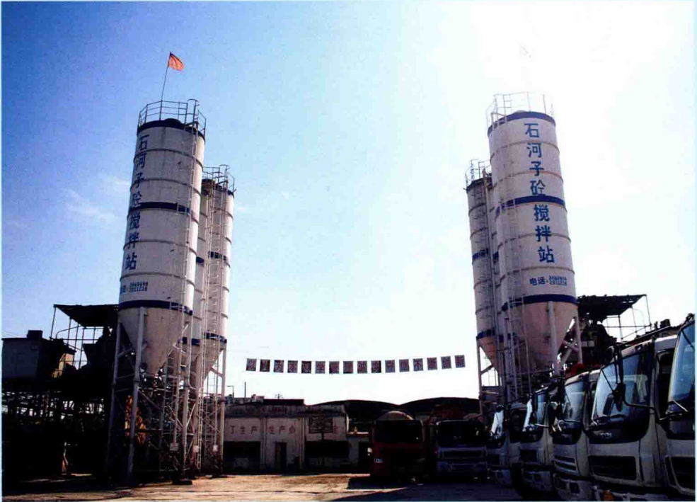
石河子砼搅拌站
