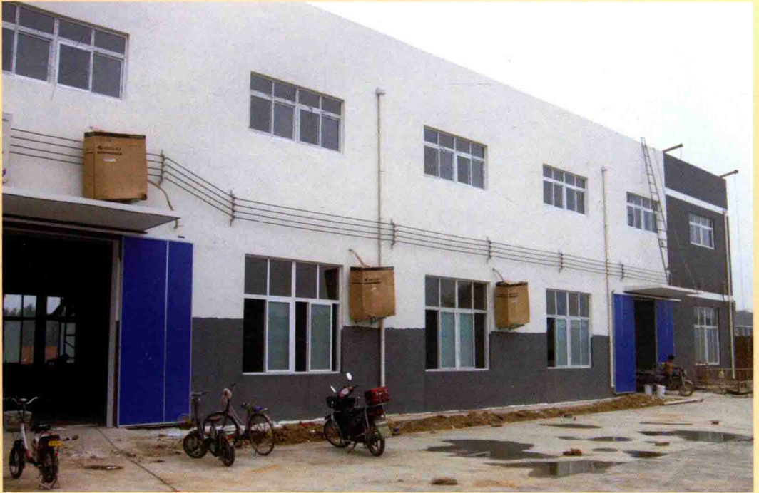
图 9 南流寺工业区新建的厂房
