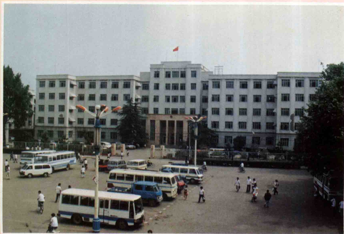
合肥市人民政府办公楼
