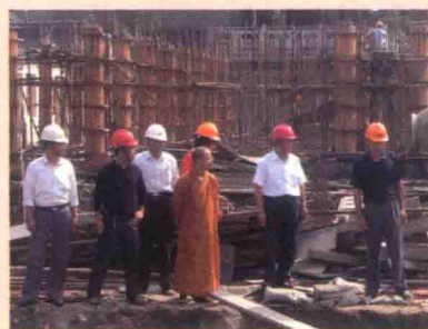
2008 年，寺院拆建工地
