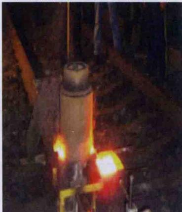
7. 线路两侧堆放的钢轨等金属路料搭接并连接普通地锚拉杆、回流线导通轨道电路,导致红光带。
