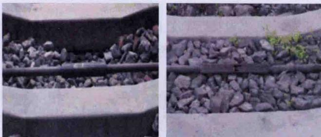
5. 起、拨道器、撬棍、扳手、拐子等金属机具、材料触碰绝缘接头及电务继电器、引入线或横向搭接钢轨,起、拨道器滑过绝缘接头均会联电导致红光带。
