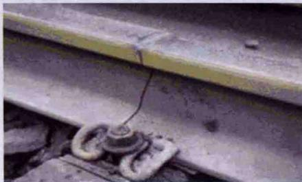
2. 绝缘接头挤死,轨端绝缘片被挤碎,短路形成红光带。
