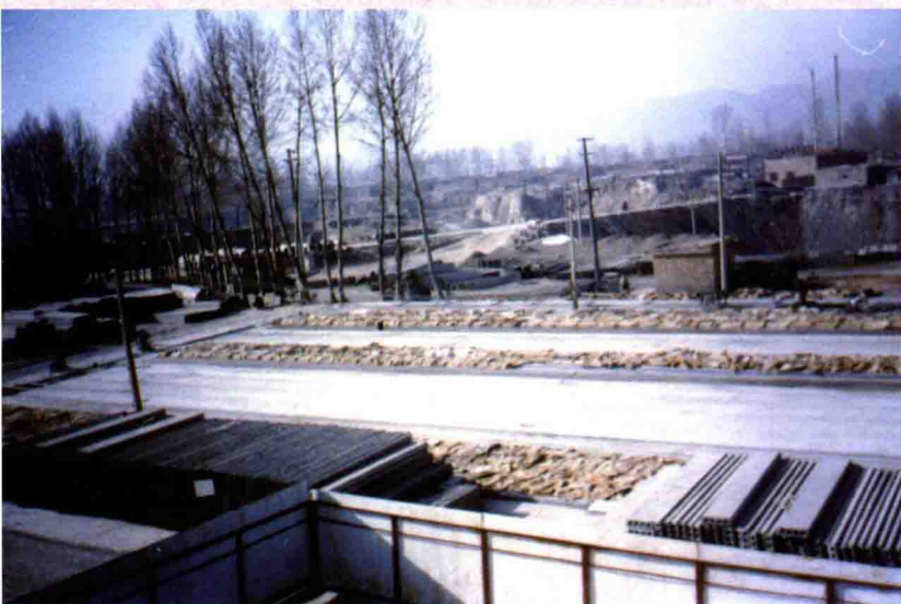
王家坪预制厂楼板生产场地
