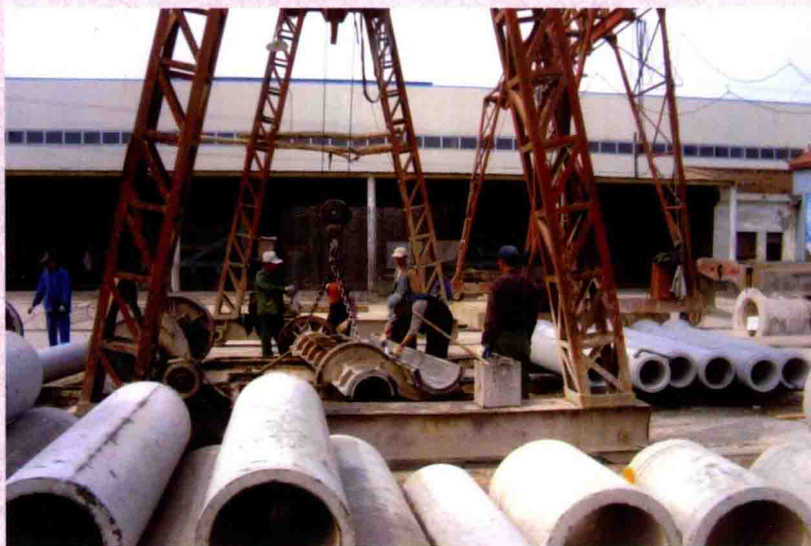
涵管生产场地
