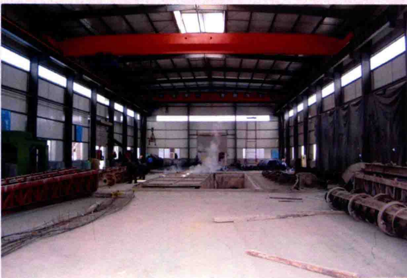
电杆生产车间
