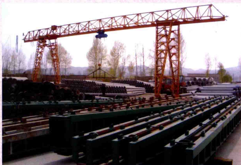
铁路电力支柱生产工地
