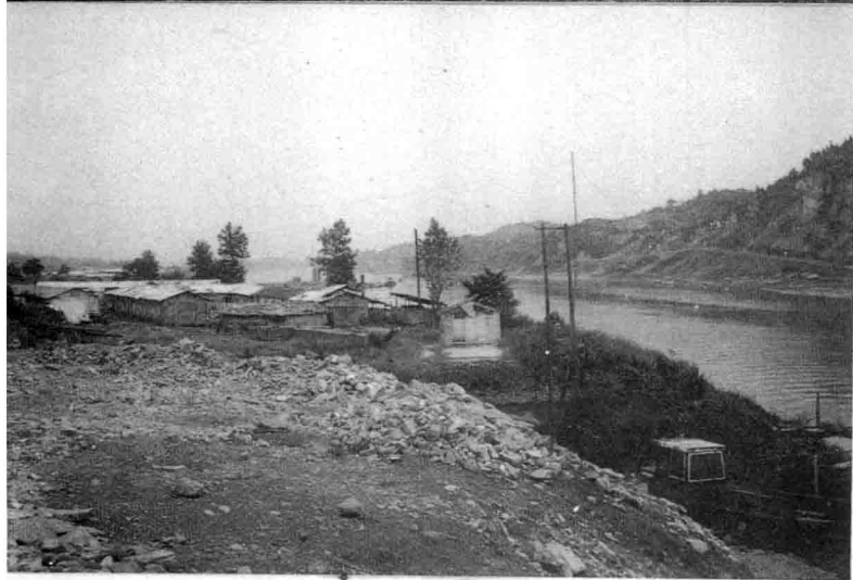
上、下图：高坝洲水电站工地
