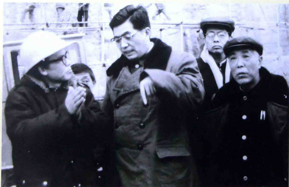
1988年3月5日，时任贵州省委书记胡锦涛（前排左二）视察在建的东风水电站施工现场
