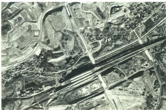
图 12：多摩中心站周边航拍（1974 年）
