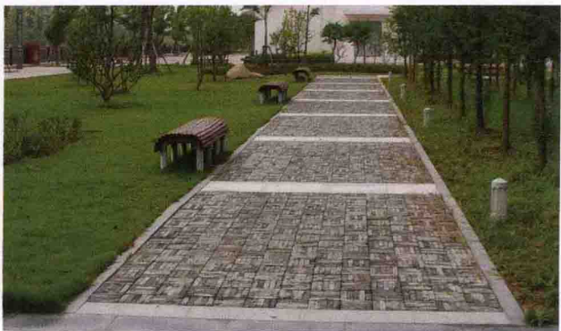
铺装方向的稍作变化，增加了青砖粗糙的质感。相间的白色面砖提亮了整体环境，与周围环境建筑的色调保持一致。
