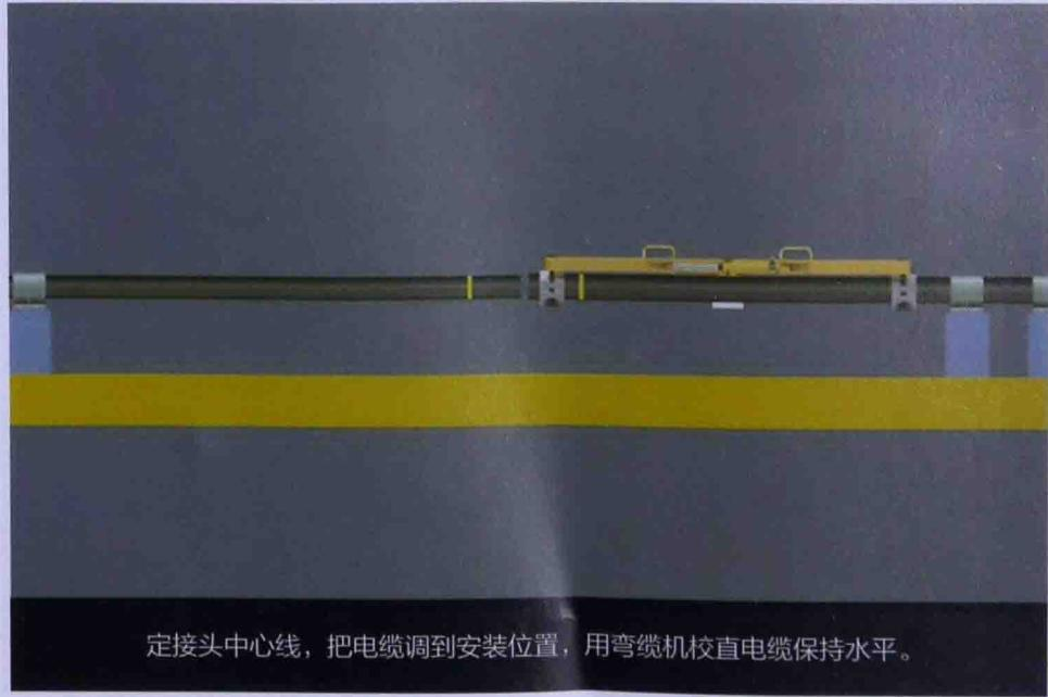
定接头中心线，把电缆调到安装位置，用弯缆机校直电缆保持水平。
