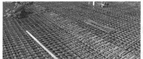
图 1-2 支架整体现浇施工的主梁顶板钢筋
