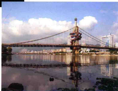
沙县悬索桥（蒋际华 摄）
