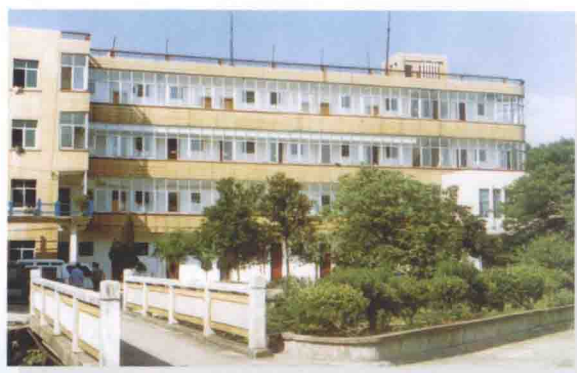
公路段办公大楼
