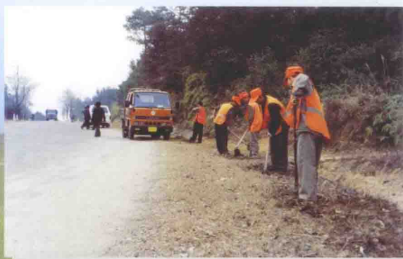
养路工在整修公路路肩
