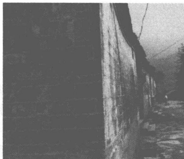
图 1.2 砖外墙土内墙混合承重
