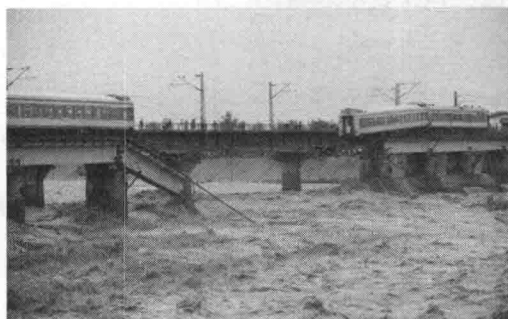
图 1-13 宝成铁路德阳至广汉间石亭江大桥事故
