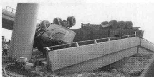
图 1-12 津晋高速公路匝道桥事故
