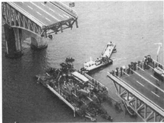
图 1-19 圣水大桥事故
