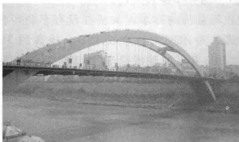
(a) 南门大桥原貌
