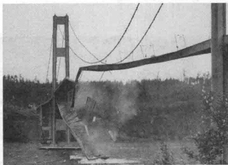
(a) 塔科马海峡大桥整体破坏
