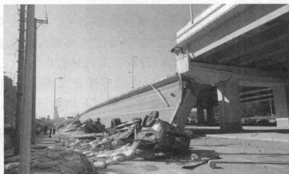
图 1-16 哈尔滨三环路高架匝道桥事故
