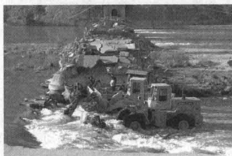
图 1-4 洮河大桥倒塌现场
