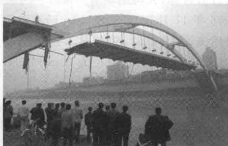
(b) 南门大桥倒塌后
