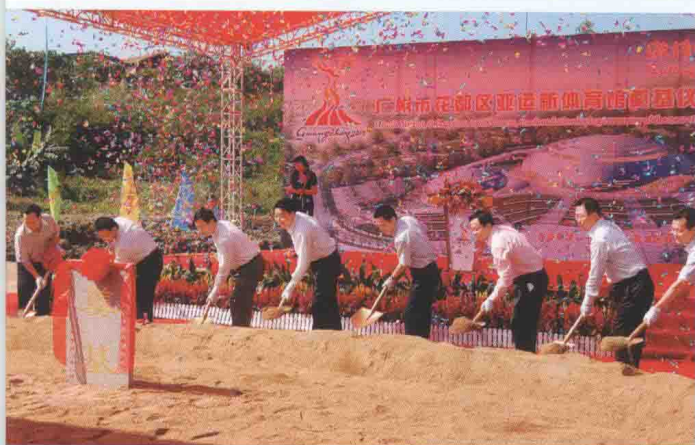
2008年10月28日，位于新华街岐山村南侧的花都区亚运新体育馆举行奠基仪式。图为市、区领导为亚运新体育馆奠基
