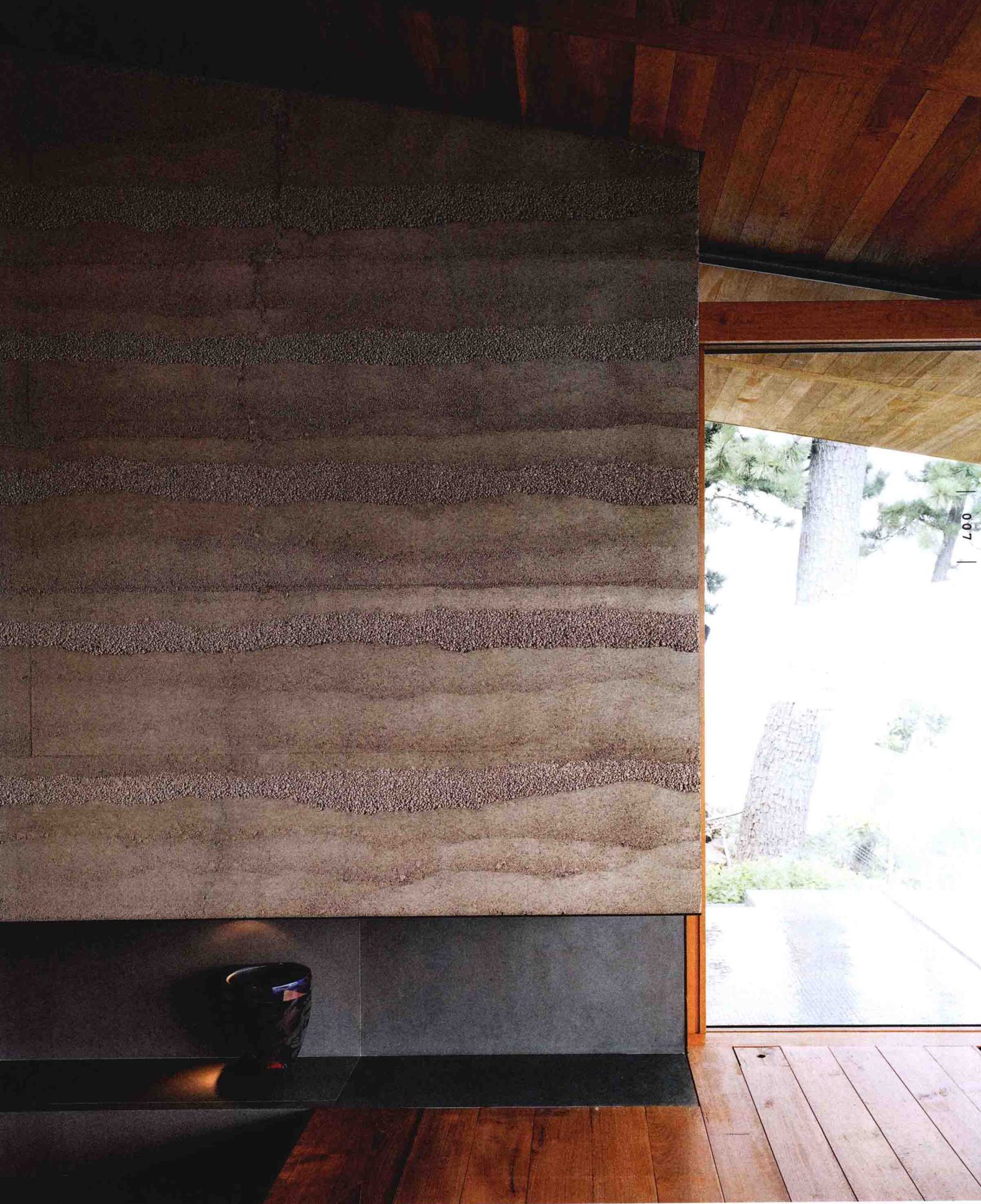
夯土墙是客厅的面孔。顶棚为 15mm 厚柚木板，Watco 涂料饰面。
