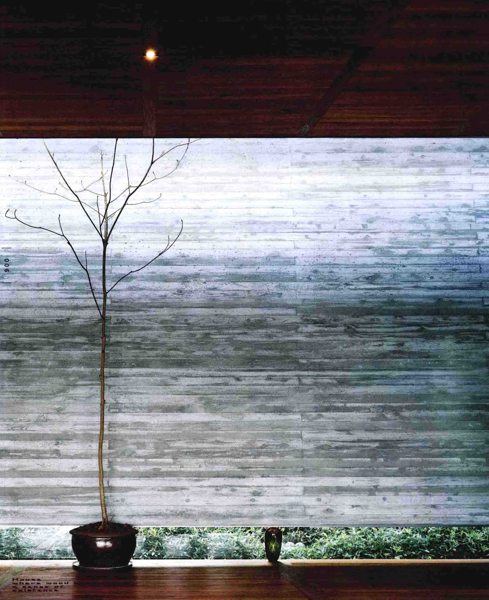
北侧内墙为杉木模板清水混凝土，涂两道 Landex 面漆。
