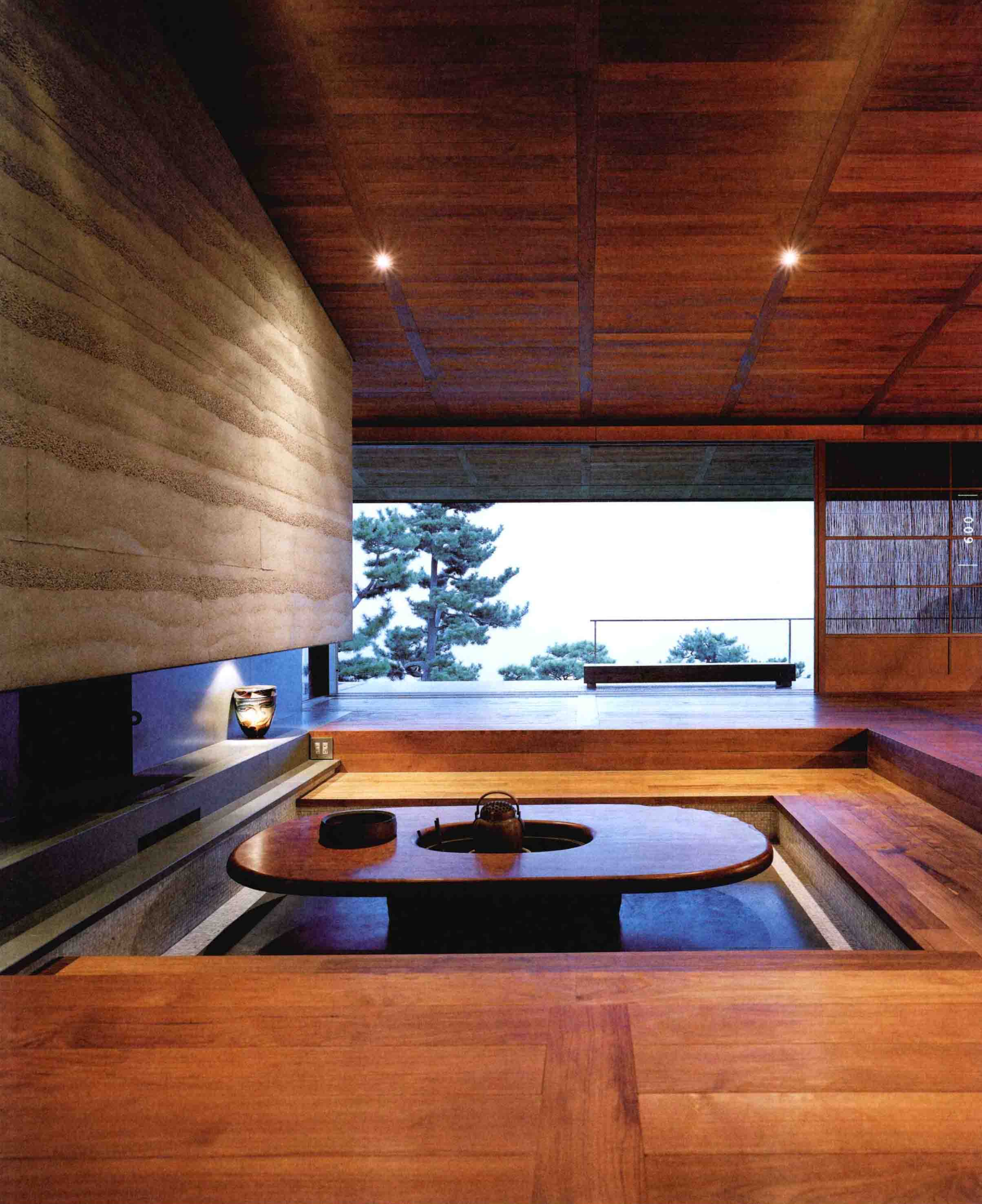
从北侧看客厅内部。中间的桌子由一整块非洲红木板制成。地板与顶棚相同，为 15mm 厚柚木板，Cerarica 天然植物蜡罩面。
