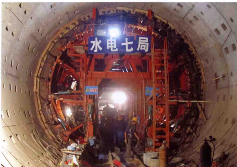
内衬钢模台车施工
