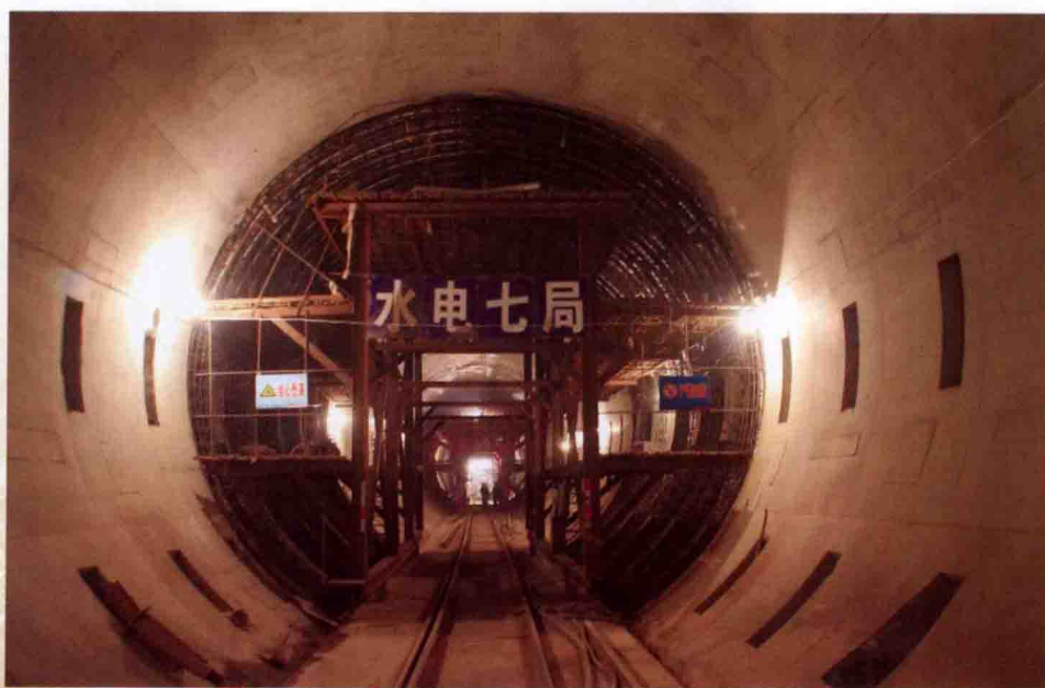
浇筑完成的预应力内衬
