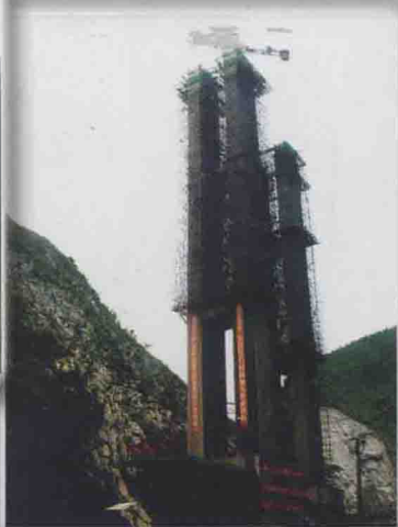
崇遵公路两岔河特大桥施工现场
