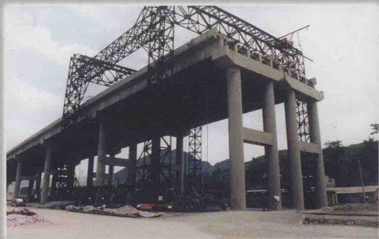
崇遵公路鞍山大桥施工现场
