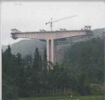
正在施工中的特大转体大桥
