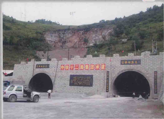
崇遵公路风梅垭隧道
