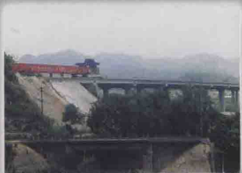
崇遵公路娄山关大桥
