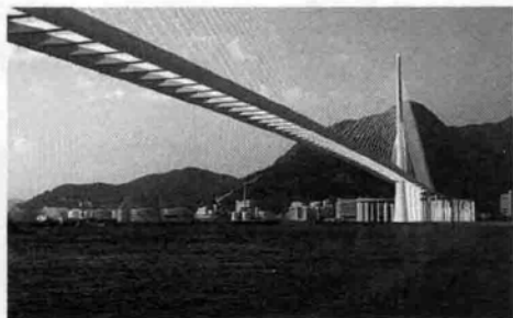
图 1.19 昂船洲大桥(2008 年)
