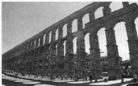
图 1.2 古罗马塞戈维亚引水渠桥(公元 109 年)
