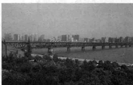
图 1.8 钱塘江大桥(1937 年)
