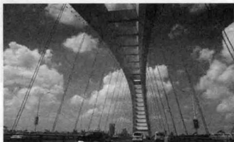
图 1.26 上海卢浦大桥(2003 年)
