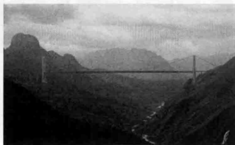
图 1.23 坝陵河大桥(2009 年)
