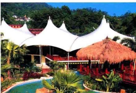
20世纪60年代随着现代柔性建筑材料的发展，建筑师们从帐篷这一最古老的简单建筑结构出发，构造出了魔幻般的形式——膜结构。此后，膜结构以其轻盈飘逸的造型，柔美并带有力量的曲线，大跨度、大空间的鲜明个性，被广泛运用在城市景观设计中，创造出具有休闲功能和艺术美的景观拉膜。景观拉膜可以构成单曲面、多曲面等不同建筑结构形式，具有优美造型的膜材特性和轻巧便利的特点。柔性的材料具有透光和防紫外线功能，夜间的灯光设计使膜结构具有鲜明的环境标志特征。它既能充分发挥建筑师的想象力，又能体现结构构件清晰受力之美，满足了建筑师对建筑与美学高度统一的要求。
