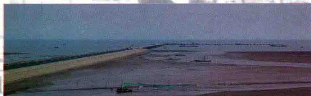
已建成的码头引堤
