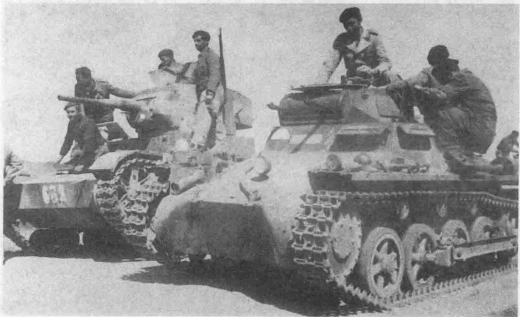
↓ 图为西班牙国民党部队与一辆虏获的苏制T-26B轻坦克和一辆德制一号坦克A型。这张照片让我们有机会可以比较一下这两款坦克。特别是它们的武装。苏制T-26B轻坦克的45毫米主炮在坦克战中享有巨大的优势。
