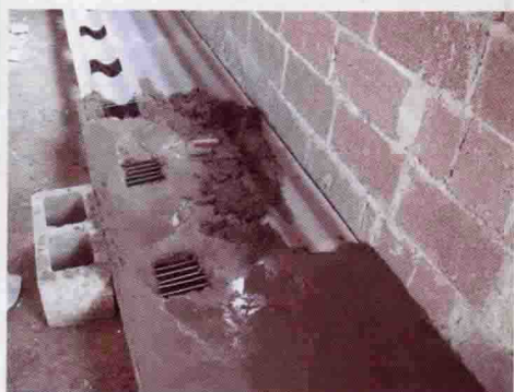
图 8：石棉瓦做底，上面抹水泥的竹鼠池地板
