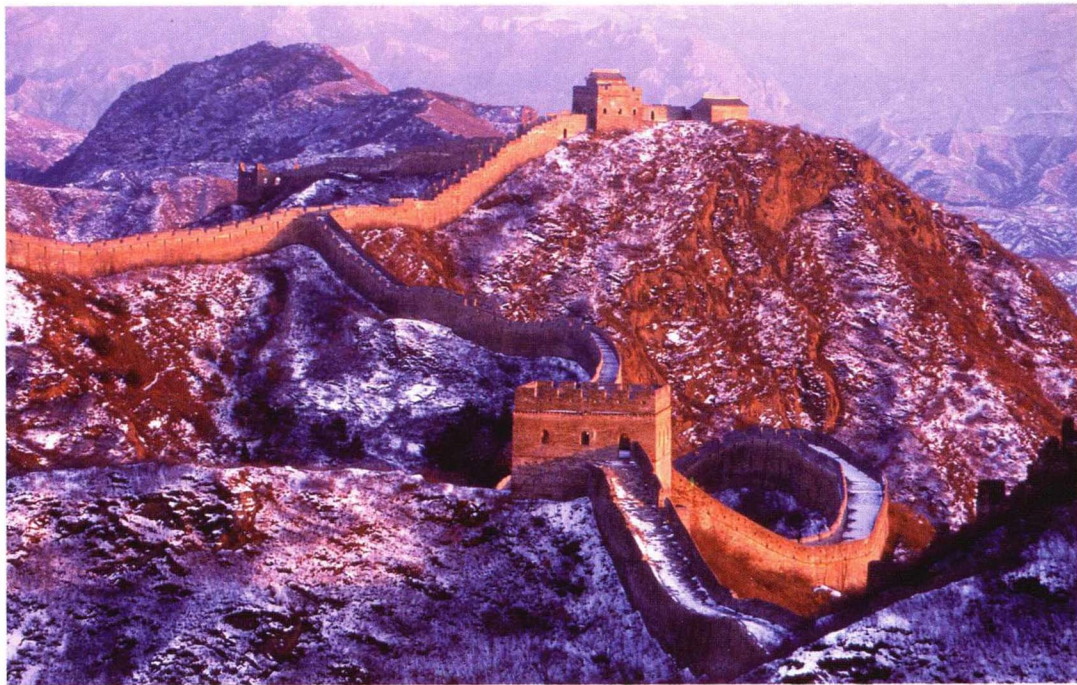
图7 北京密云金山岭长城为石基砖砌，两面垛口，号称一等边
