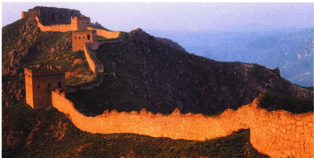
图8 河北涞源县用毛石砌合的长城
