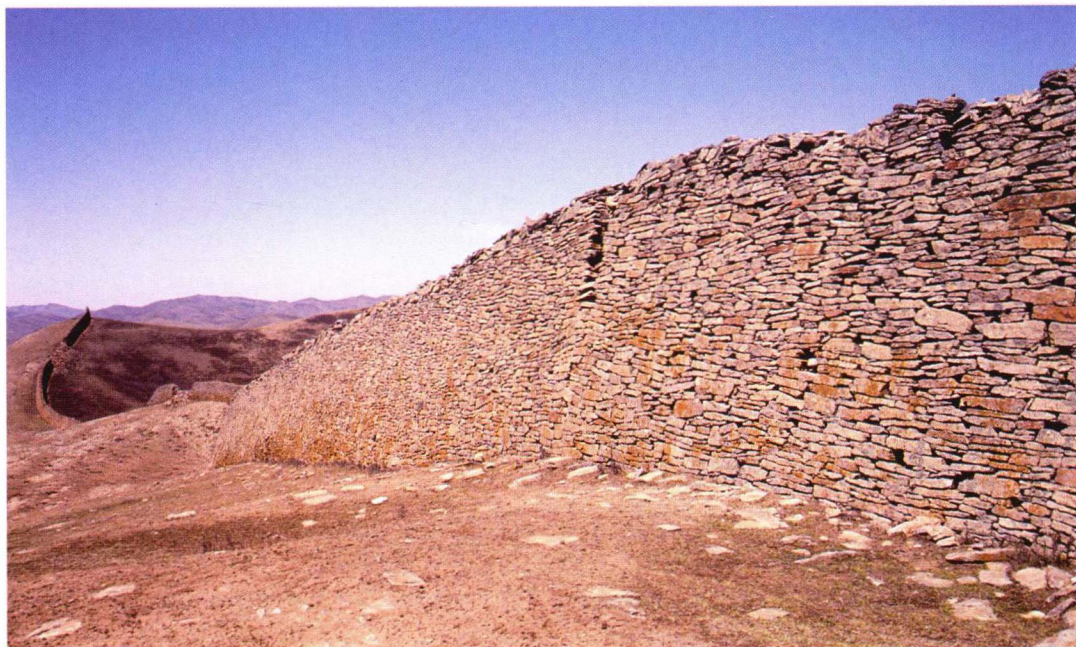
图 10 河北赤城县用片石干垒的封顶长城，俗称干插边
