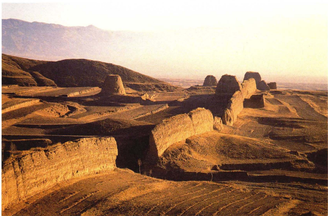
图9 山西天镇县的夯土封顶长城，沿墙设骑墙战台和护城墩
