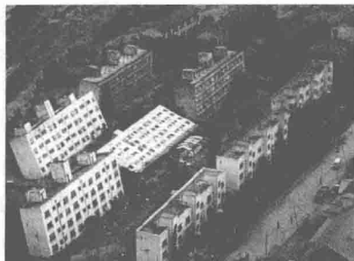
(a) 1964 年日本新潟地震中建筑物的破坏
