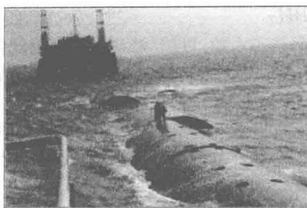
(a) 岛堤破坏照片
