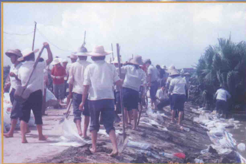
在6月的特大洪水中，东风镇干部和群众加固防洪干堤。
