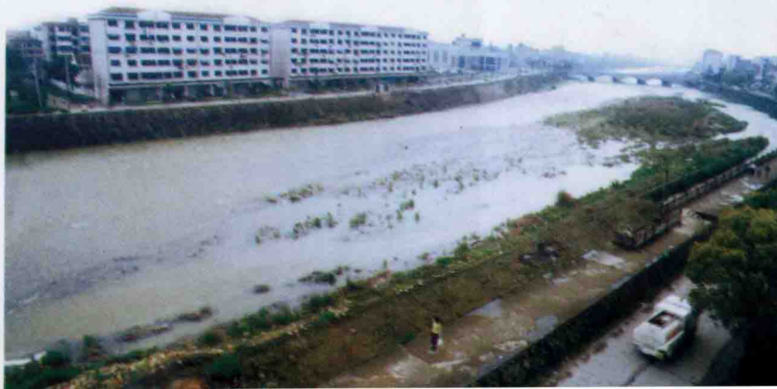
►治理后的南苕溪防洪大坝锦城镇段
