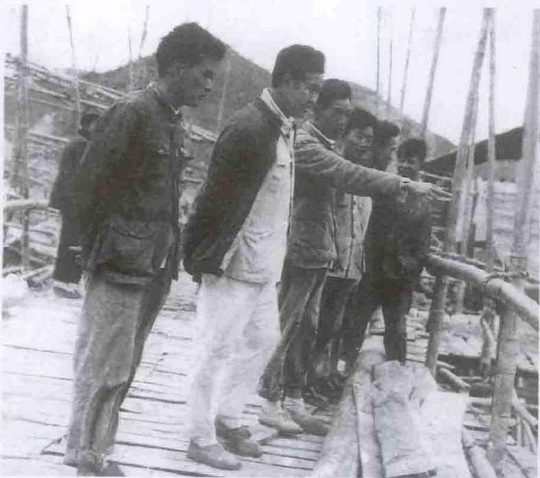
▲1960年5月，中共临安县委书记王茂松（左二）、县长兼青山水库工地总指挥黄太和（左三）在青山水库建设工地检查施工情况。
