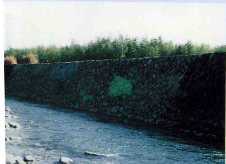
▼修复后南苕溪大坝
