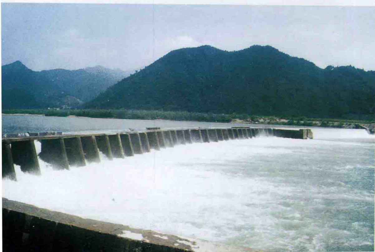
◀ 乐平乡西乐水电站大坝活动翻板闸门
