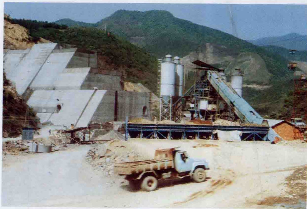
►建设中的水涛庄水库
